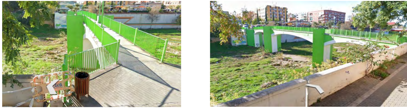
Figura 5. Pasarela Almassereta antes de la DANA. Vistas desde el margen este.
