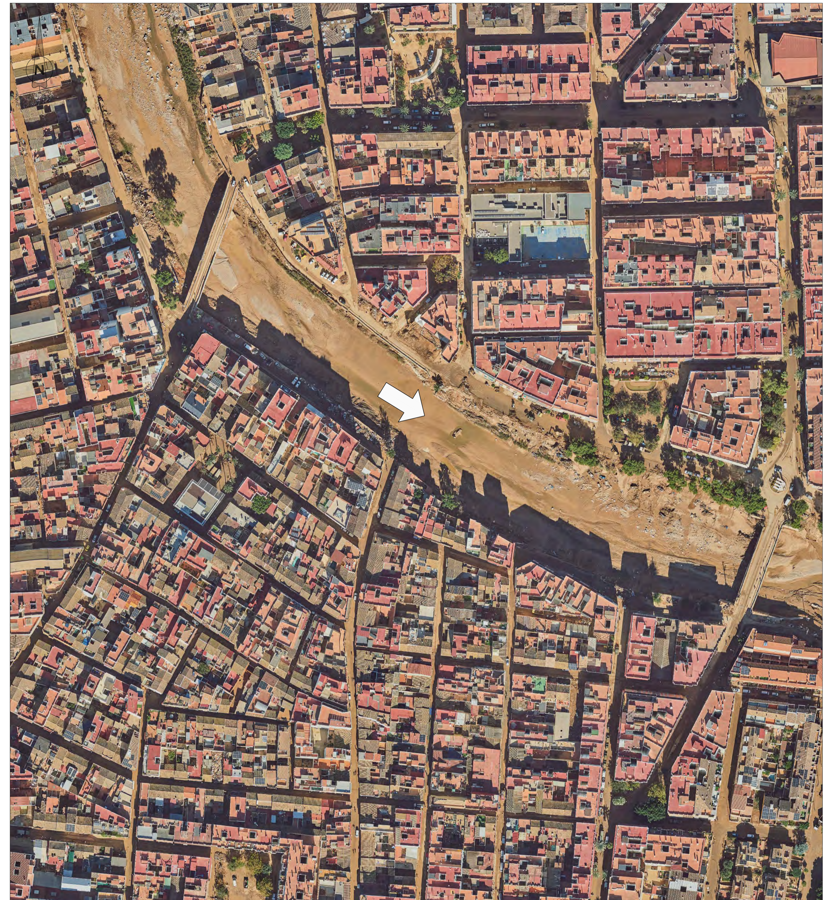
PASARELA CONVENT (PAIPORTA)
