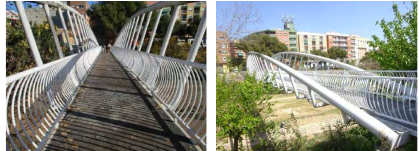
Figura 7. Pasarela Carrer Convent antes de la DANA
