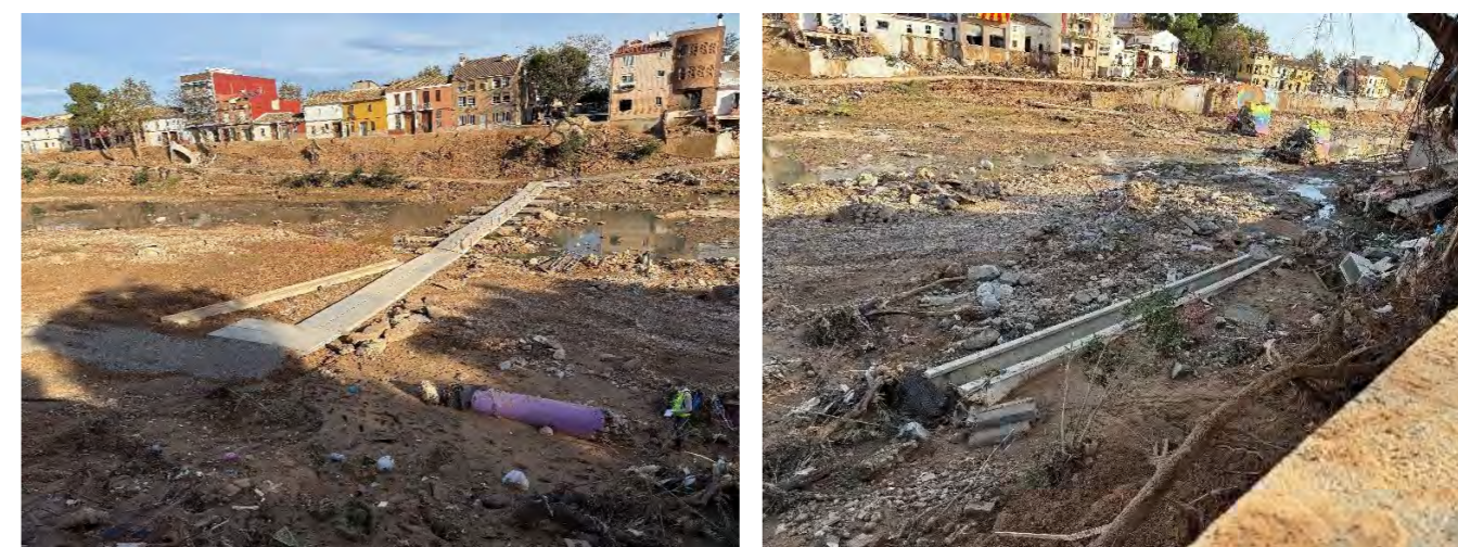
Figura 4. Pasarela María Cambrills después de la DANA. Vista desde el estribo sur (izda). Vigas del tablero en la orilla sur, unos metros aguas abajo del emplazamiento original (dcha).
