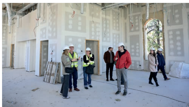
L'alcalde, Vicent Ciscar, junt amb la vicealcaldessa, Marian Val, i el regidor de Reconstrucció, Alejandro Sánchez, comproven l'avanç dels treballs del futur Centre de Dia.
