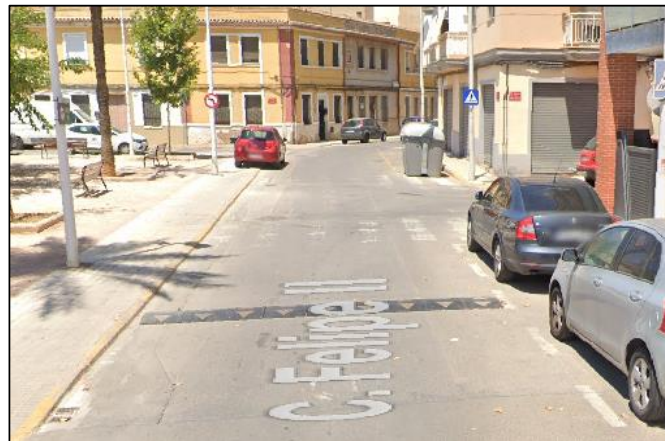
Ilustración 7. Situación actual de la calle Felipe II. Fuente: Google Maps.
