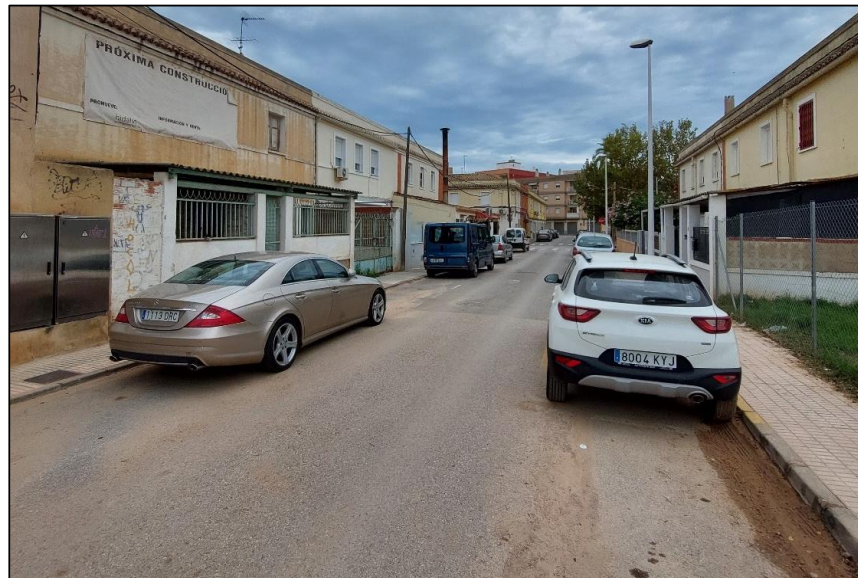
Ilustración 5. Situación de partida de la calle Don Juan de Austria. Fuente: Elaboración propia
